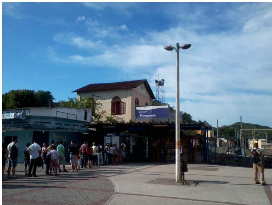
Figura 11 – Estação de Trem de Paracambi (Atual) Fonte: Arquivo Pessoal (2013)
